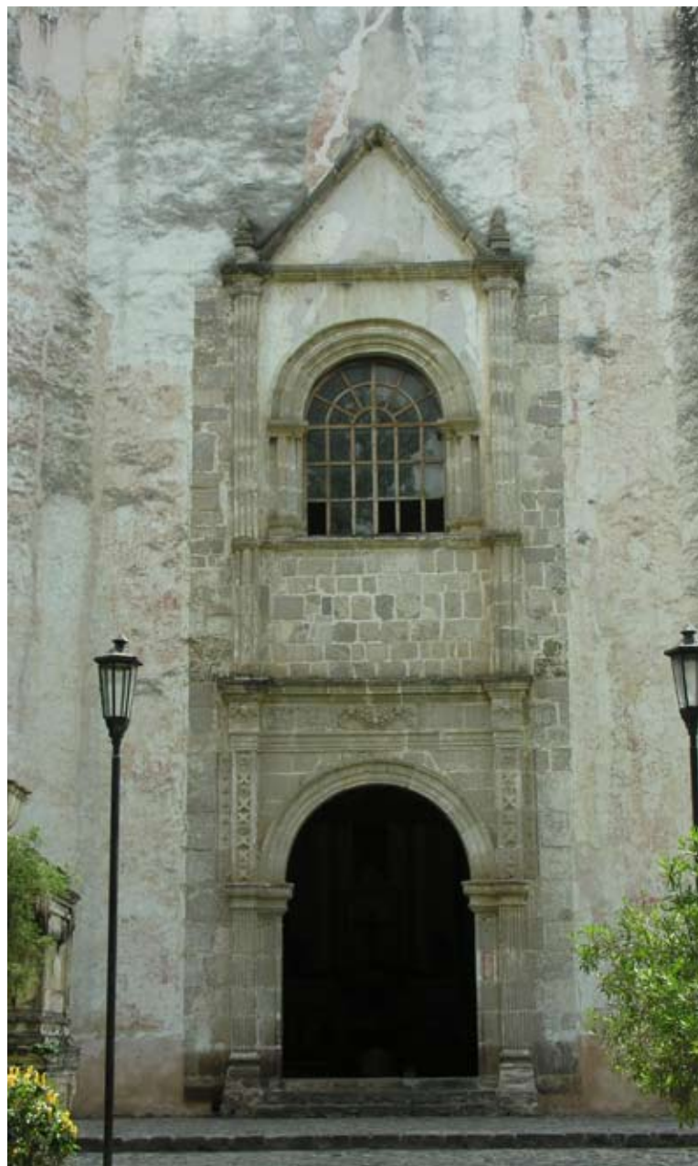
Convento agustino de Tlayacapan en el estado de Morelos. Fotografía: Carlos Alvarado
